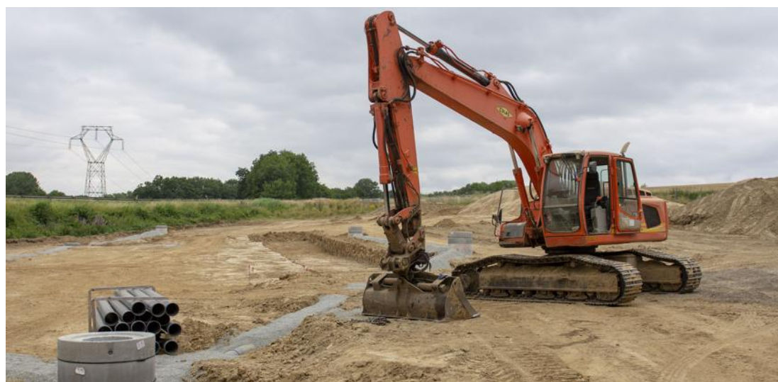
Les travaux de terrassement et d'assainissement ont débuté le 11 juin.
